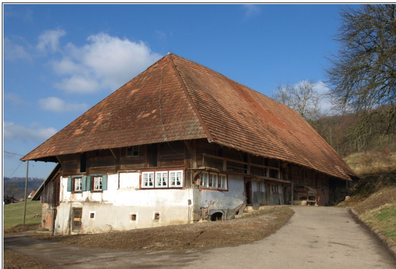
Roserhof, Höhenhaus von 1766 (i) im mittleren Schwarzwald (Gemeinde Sexau, Landkreis Emmendingen, BW). Fachwerk und Ständerbohlenkonstruktion über massivem Sockel. Foto: Burghard Lohrum
